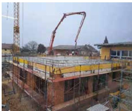
Im Dezember wurde auch noch die Decke des Erdgeschoss gegossen.
